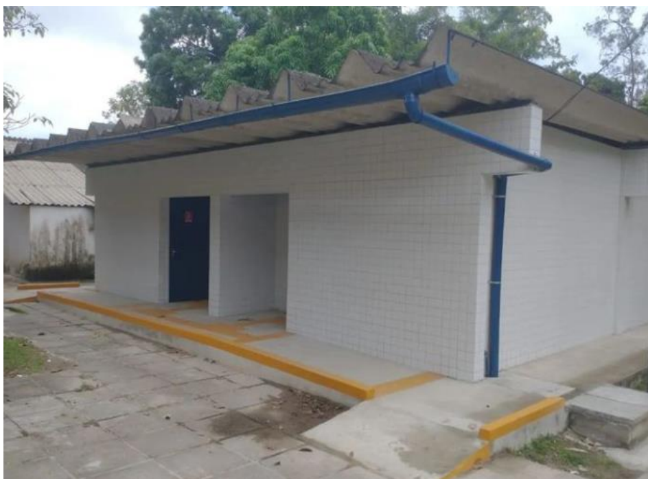
Figura 41 - Construção sustentável - banheiro com coleta de água de chuva
