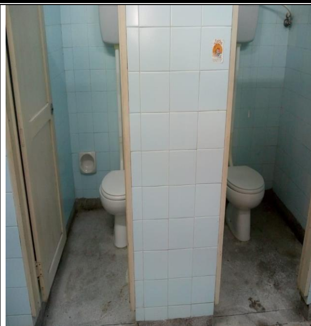
FOTO DEPOIS: ASSENTO SANITÁRIO NOVO
