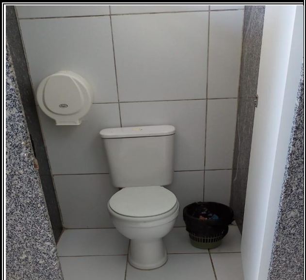
FOTO DEPOIS: COM ASSENTO SANITÁRIO NOVO
