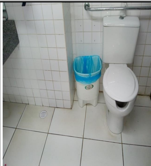
FOTO DEPOIS: COM TAMPA DO RALO E ASSENTO SANITÁRIO
