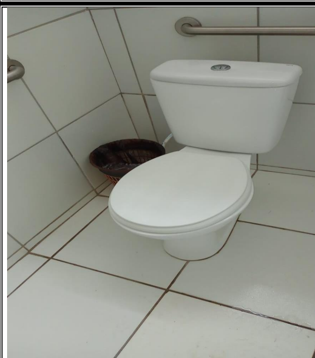
FOTO DEPOIS: COLOCAÇÃO DO ASSENTO SANITÁRIO
