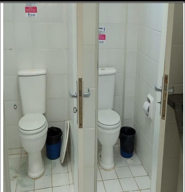
FOTO DEPOIS: COLOCAÇÃO ASSENTO SANITÁRIO E TROCA DO REPARO
