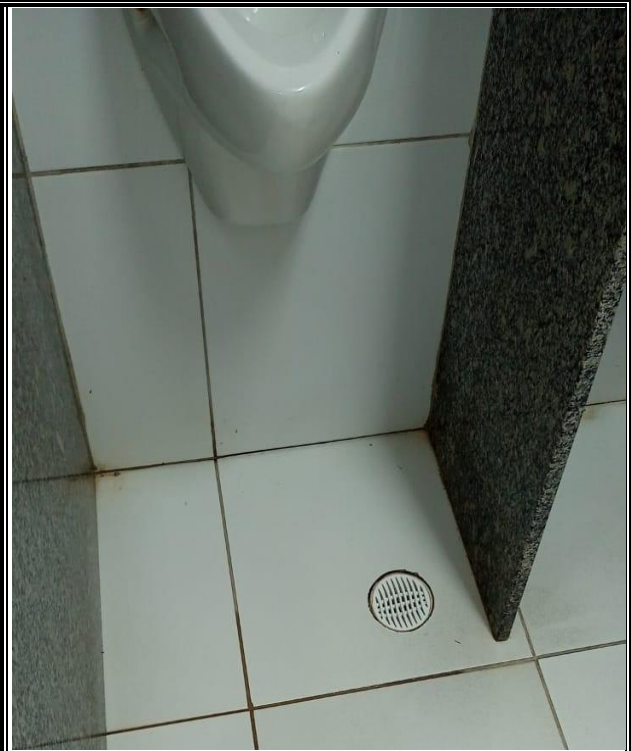
FOTO DEPOIS: TAMPA DE RALO NOVO
