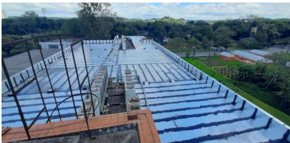
Figura 83 - Recuperação de telhados
