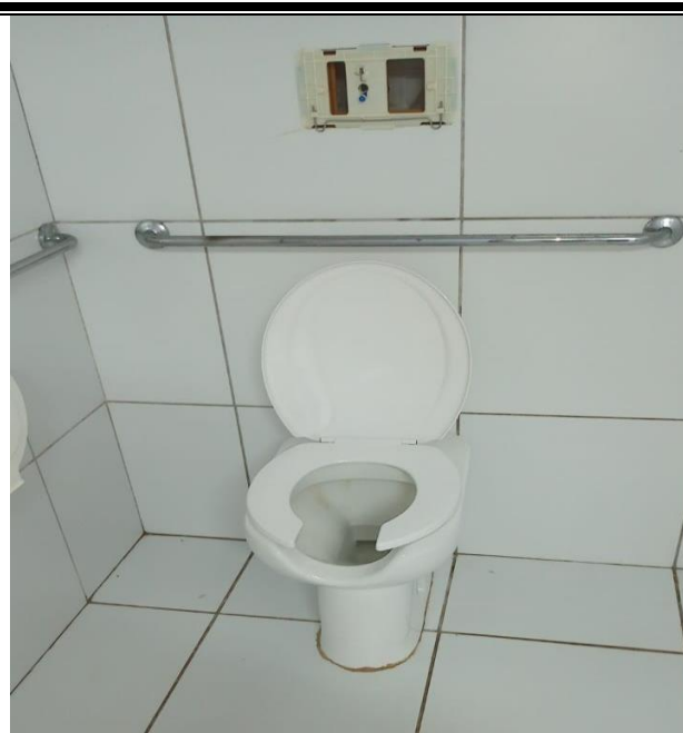
FOTO DEPOIS: : COM ASSENTO SANITÁRIO
