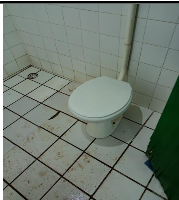
FOTO DEPOIS: COLOCAÇÃO DO ASSENTO SANITÁRIO
