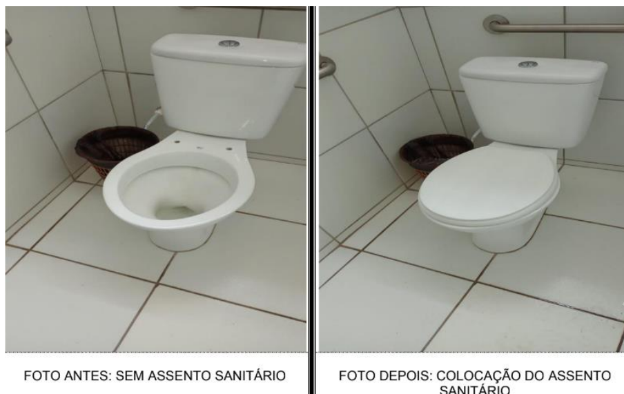
Figura 104 - Serviços de manutenção nos banheiros
