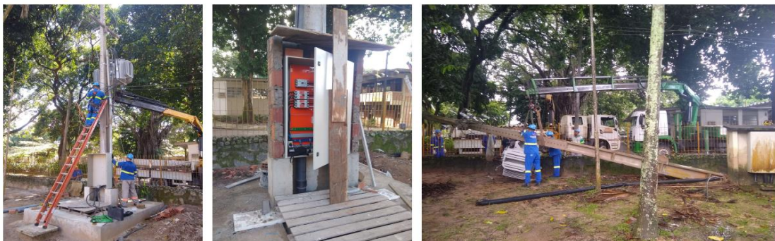
Figura 52- Manutenção elétrica - CEGOE - 2022
