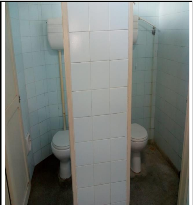
FOTO DEPOIS: COM ASSENTO SANITÁRIO E DESCARGA NOVA
