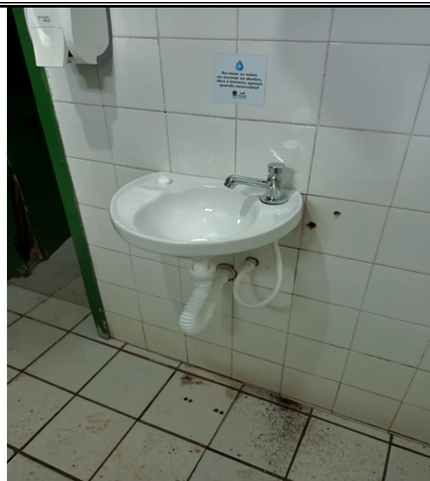
FOTO DEPOIS: TROCA DA TORNEIRA, PIA, SIFÃO E ENGATE NOVOS
